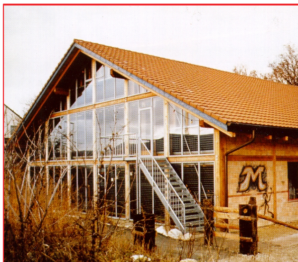
Les capteurs à air sont intégrés à la façade de la maison des jeunes à Reinach, Suisse (arch. Archico).
