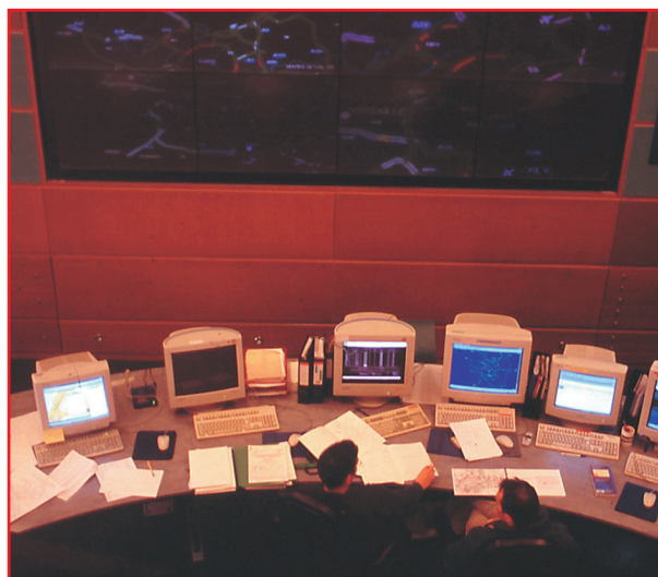
Contrôle des flux dans la ville au Service interdépartemental d'exploitation (SIER) d'Île-de-France (source : ministère de l'Équipement).
