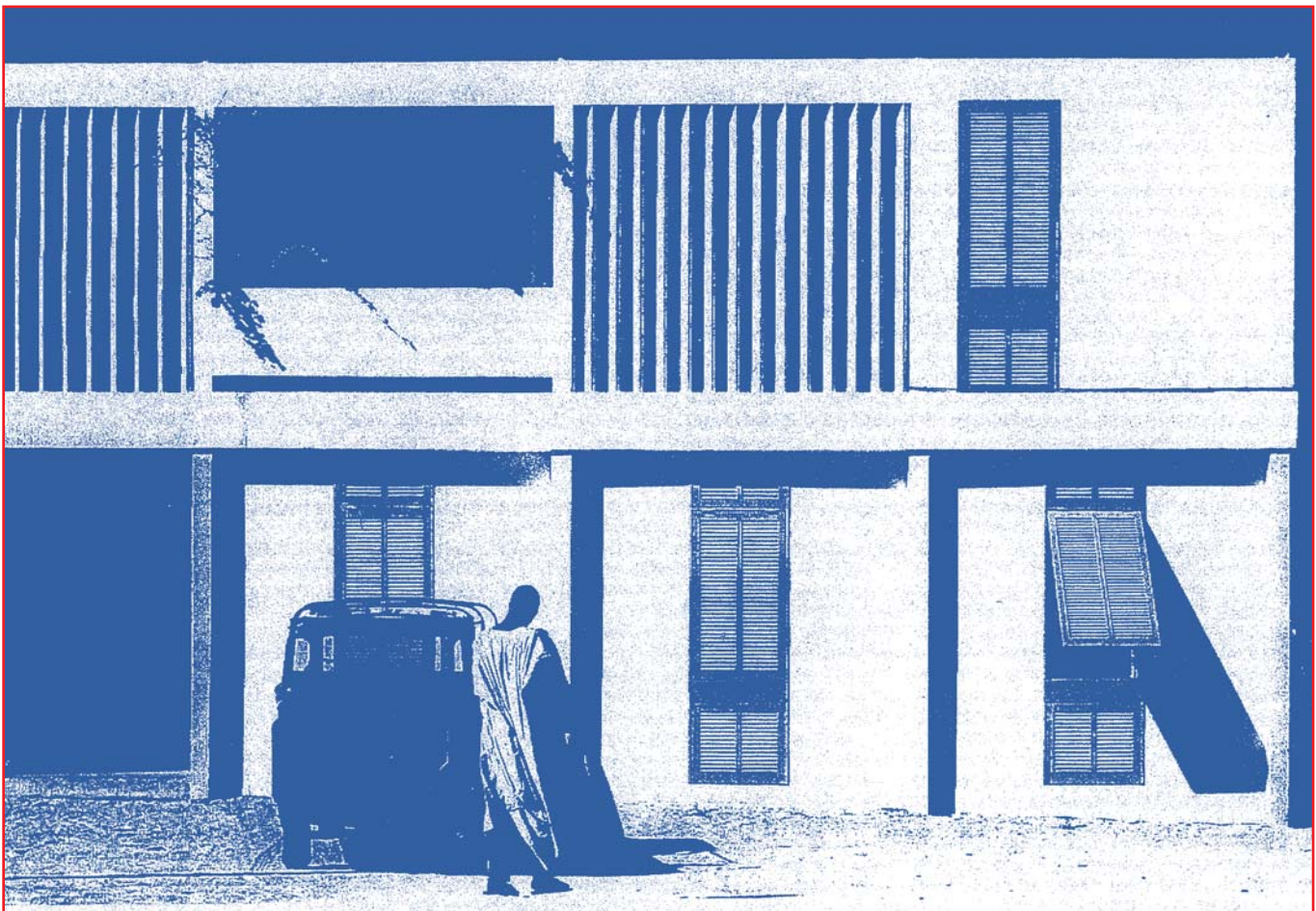
2 Différents types de protection d'une même façade (Sénégal).
