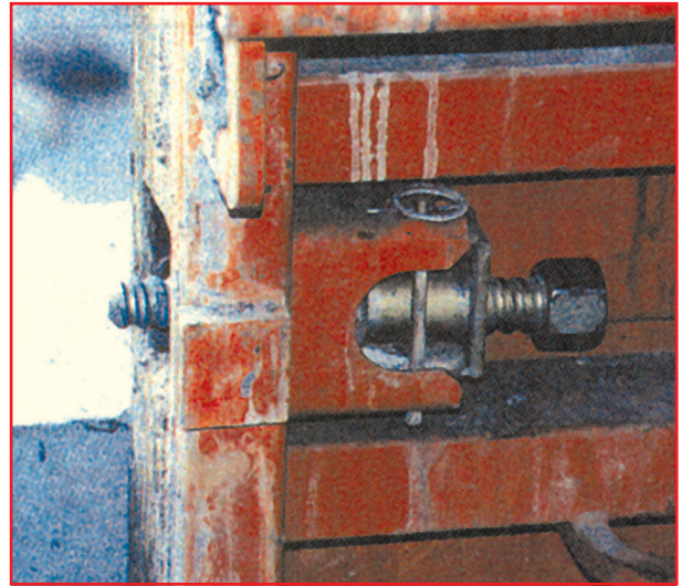
1 Serrage à clé pour coffrages (PUCA - Plan Urbanisme Construction Architecture).
