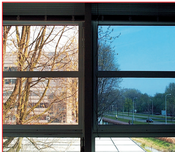
Vitrage électrochromes en phase de coloration (à droite) ou de décoloration (à gauche). 1
