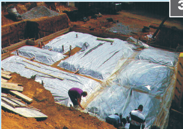
2 Étanchéification et drainage du sol (Centre Scientifique et Technique de la Construction – Belgique).
