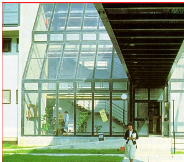
1 Les fenêtres orientées au sud et la serre fournissent 22 % des besoins nets de chauffage (arch. Coop Citta e Territorio).
