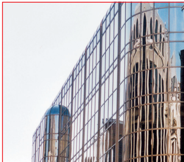
Les vitrages réfléchissants agissent 1 comme des miroirs en renvoyant l'image des bâtiments voisins.
