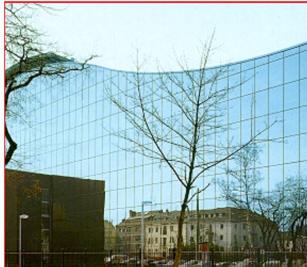
Le choix du vitrage détermine la quantité de lumière transmise et réfléchie vers l'environnement.
