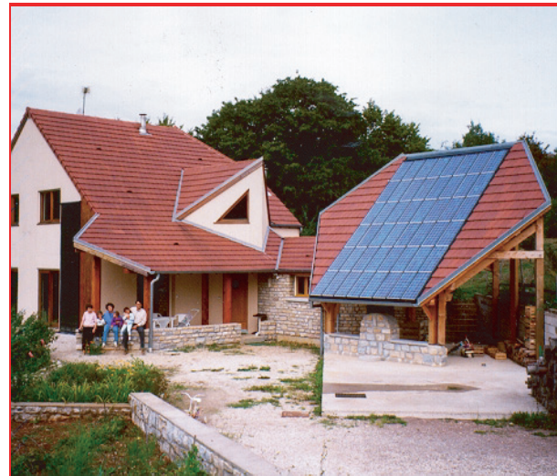
Maison Legard à Besançon 1 (arch. A. Combet).
