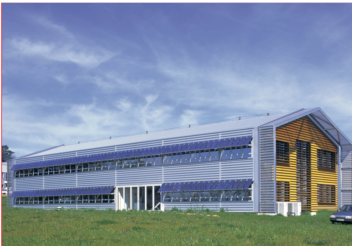
2 Brise-soleil photovoltaïques translucides sur la façade sud du siège social de Total Énergie (La Tour de Salvagny - France) (arch. J. Ferrier).
