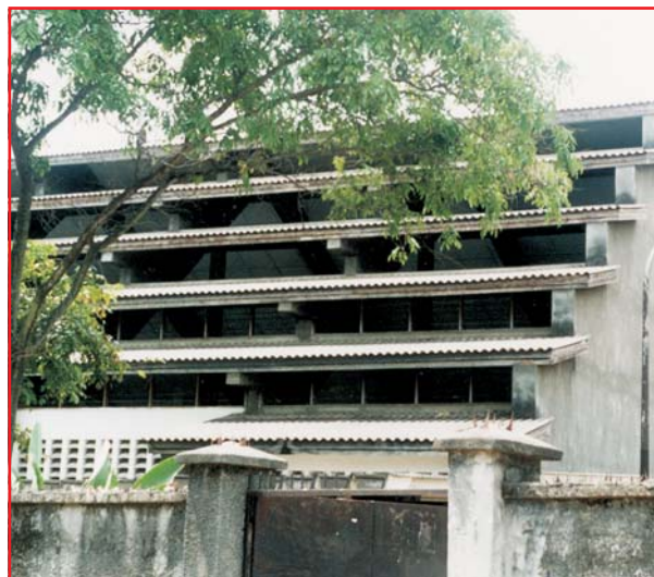
Toiture au vent de l'église Saint Augustin de Kinshasa (Rép.Dém. du Congo) (arch. P. Dequeker).
