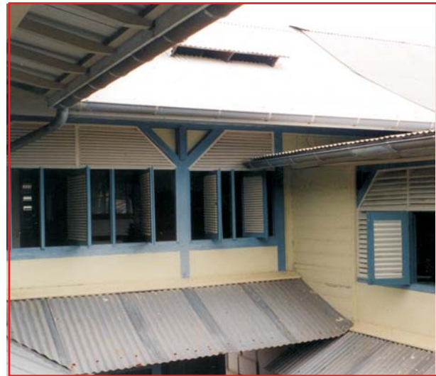
Ecopé en toiture d'une maison traditionnelle à Cayenne (Guyane Française).
