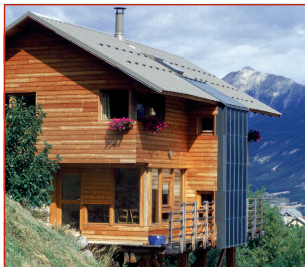
Maison à ossature bois à Puy Saint André (France) (Architecte : E. Boissel). 1
