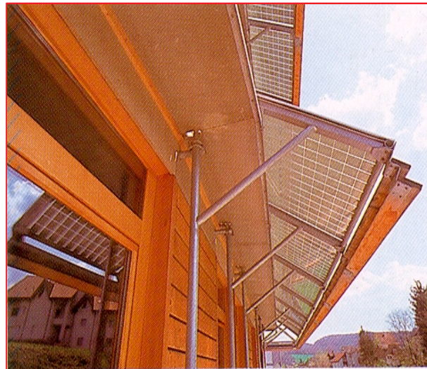
1 Intégration des panneaux PV en tant que protection solaire en Suisse (arch. Artevetro).
