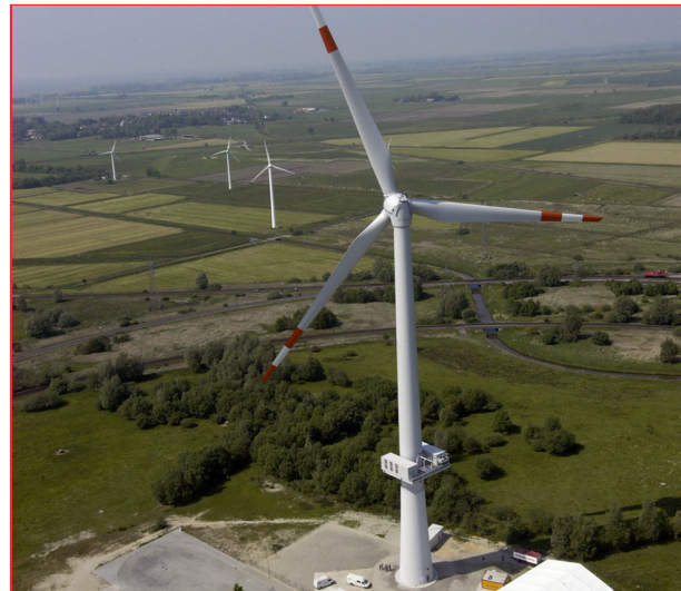
1 Prototype d'une des plus puissantes éoliennes installées, la Multibrud M5000 de 5 MW, développée par le groupe allemand Prokon Nord.
