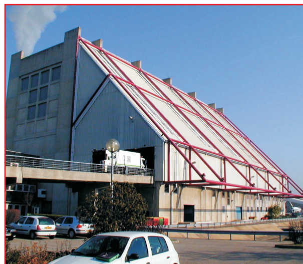
L'Usine d'incinération des ordures ménagères (UIOM) du Grand Lyon dont la production de vapeur est transformée en électricité.
