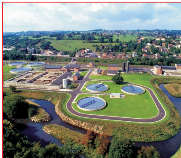
Station d'épuration de Wegnez 1 (Belgique).
