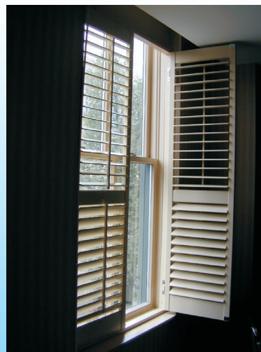
Exemple d'une protection solaire intérieure. 1
