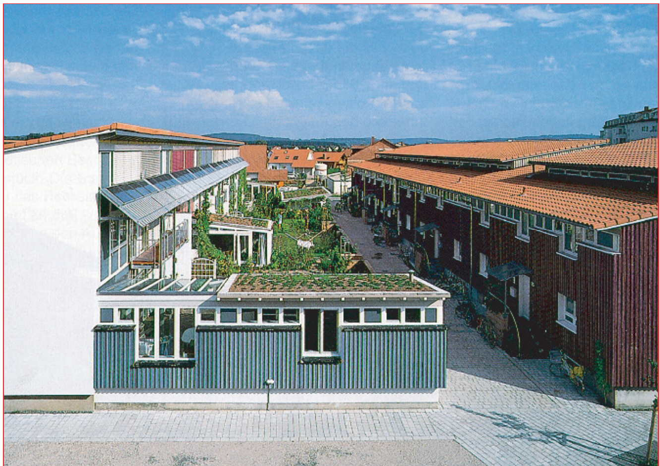
2 Cité écologique "Geroldsacker", à Karlsruhe, Allemagne (arch. Löffler & Schneider).
