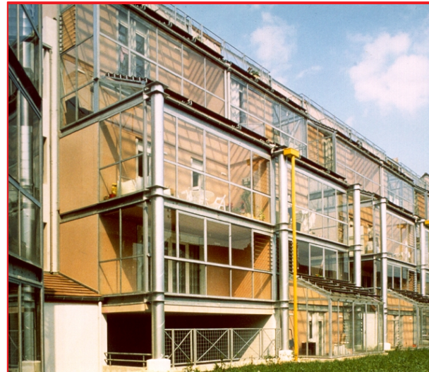
1 Les serres sont placées en espace tampon entre l'ambiance extérieure et la paroi des logements, Dijon (arch. Dubosc - Landowski).
