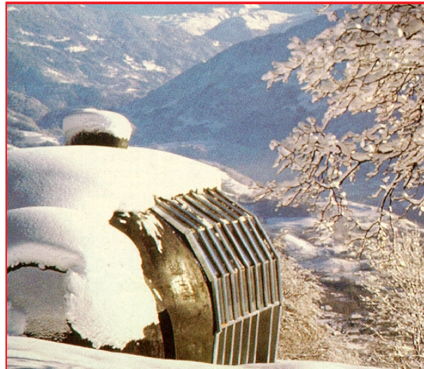
L'hostilité de l'environnement invite parfois à des formes ramassées (arch. Agence Chaneac).
