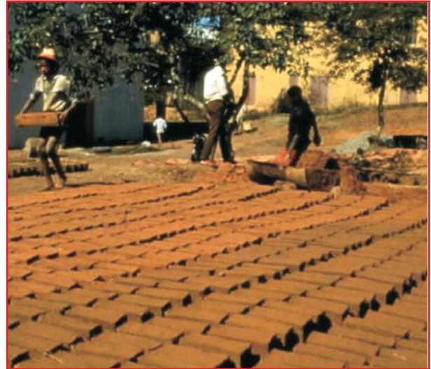
1 Production de briques de terre crue séchées au soleil (Madagascar).
