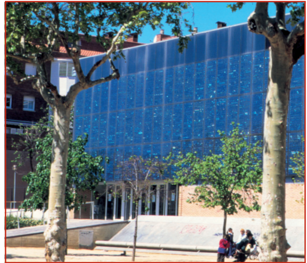
Panneaux photovoltaïques sur la façade Sud de la bibliothèque de Mataro (Espagne) (Architecte Miquel Brullet).
