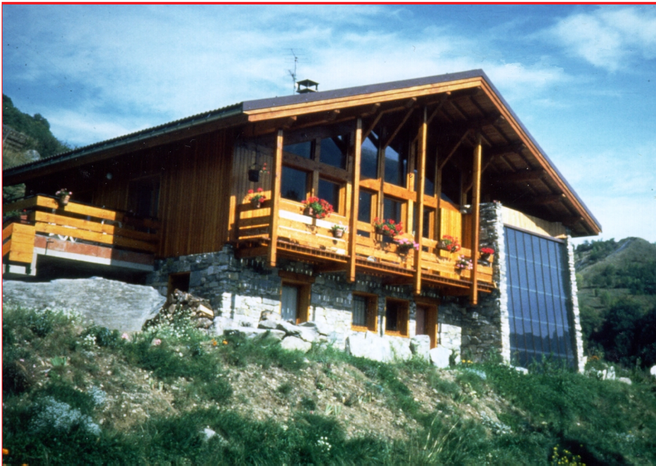
2 Les capteurs solaires sont installés en façade sud de la maison.
