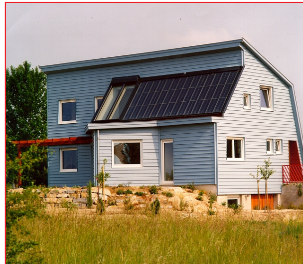
1 Capteurs à eau en toiture, alimentant un plancher solaire direct, à Mulhouse (arch. B. Mosser).
