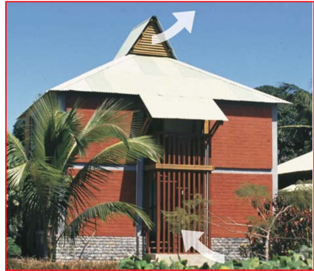
Ouvertures favorables à une ventilation nocturne par effet de cheminée (Mayotte). 1
