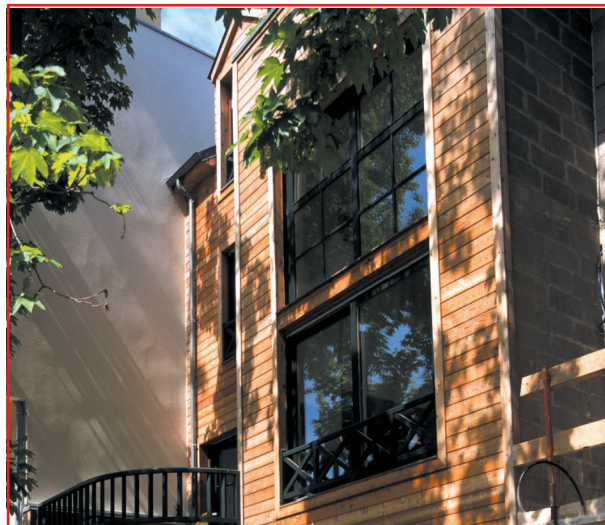
Maison individuelle à Haute Qualité Environnementale située à Neuilly-sur-Seine (France) (Architecte Bruno Boschetti). 1
