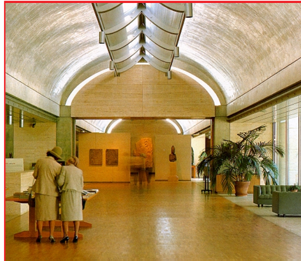
Contrôle de l'éclairage direct et indirect dans le Kimbel Art Museum de Fort Worth, Texas (arch. L. Kahn). 1
