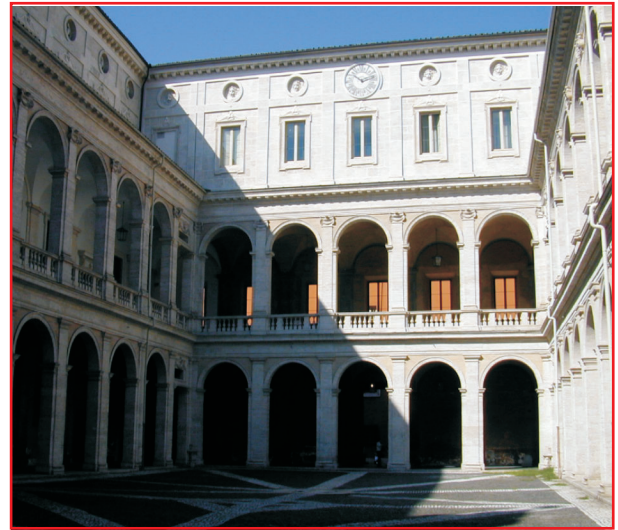
Une cour (arch. F. Borromini). 1
