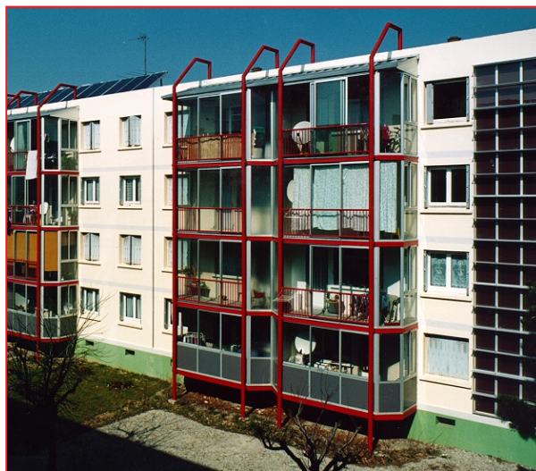
1 Vue d'ensemble de la Cité Mazorel après réhabilitation. Sur le toit-terrasse : les capteurs solaires (arch. S. Jauré).
