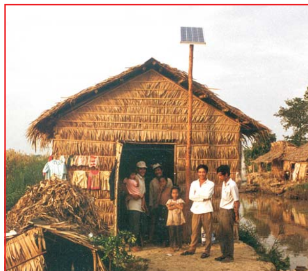
Electrification photovoltaïque en zone rurale (Vietnam).
