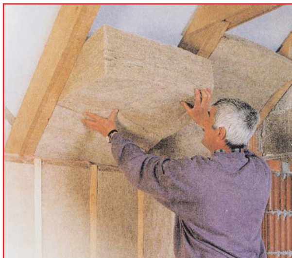
Pose de panneaux de chanvre. 1
