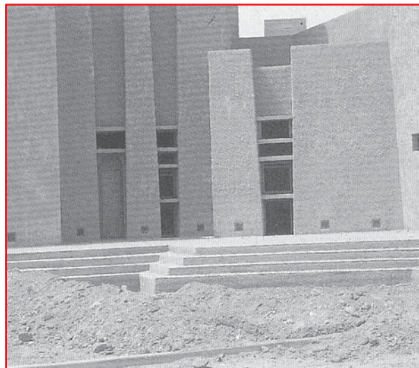
Façade d'entrée de la cour d'appel de Niamey (Niger) (arch. C. et L. Mester de Parajd).
