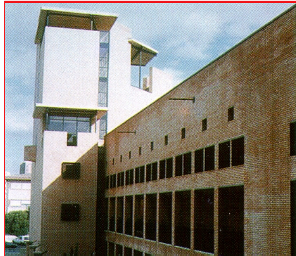
1 Vue de la façade ouest et de la tour nord du Conservatoire de musique (arch. C. Luis-Carréa Cangas).
