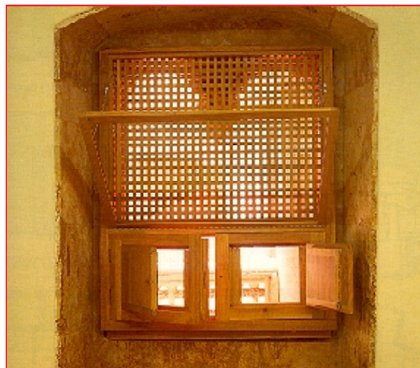
1 Les multiples protections de la fenêtre contre l'excès de soleil (Salamanque, Espagne).
