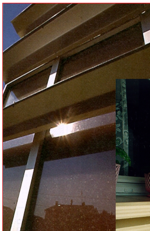
Mur Trombe doté d'un isolant transparent
