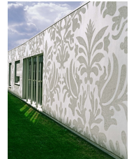
Label 2014 Détail de façade de l'EHPAD
