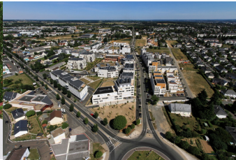
Label 2014 Vue aérienne entrée ouest
