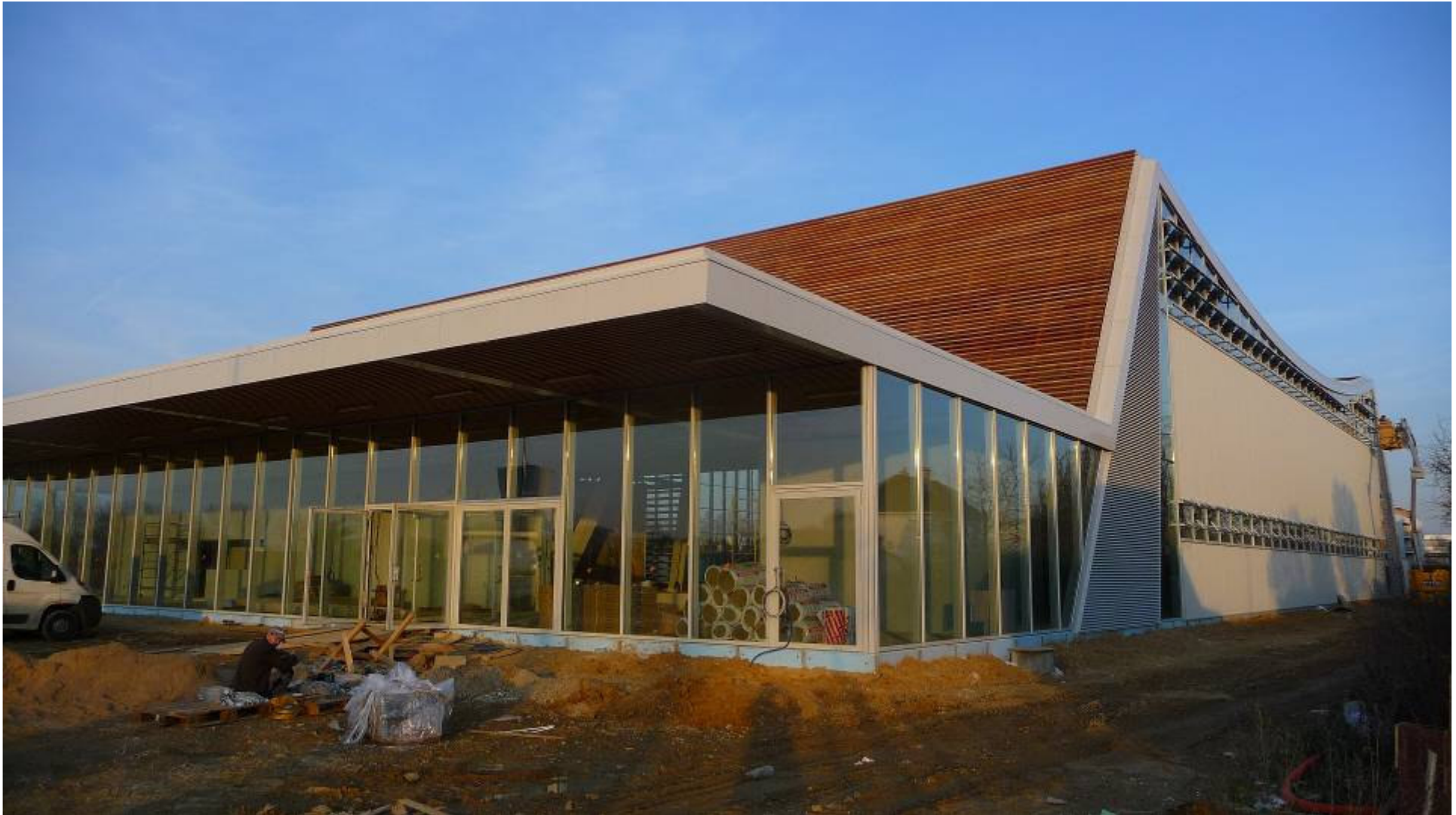
Pose des panneaux solaires
