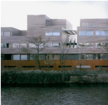
Logements intermédiaires - Gant, Belgique 1993-98 Neutelings/Riedijk architectes
