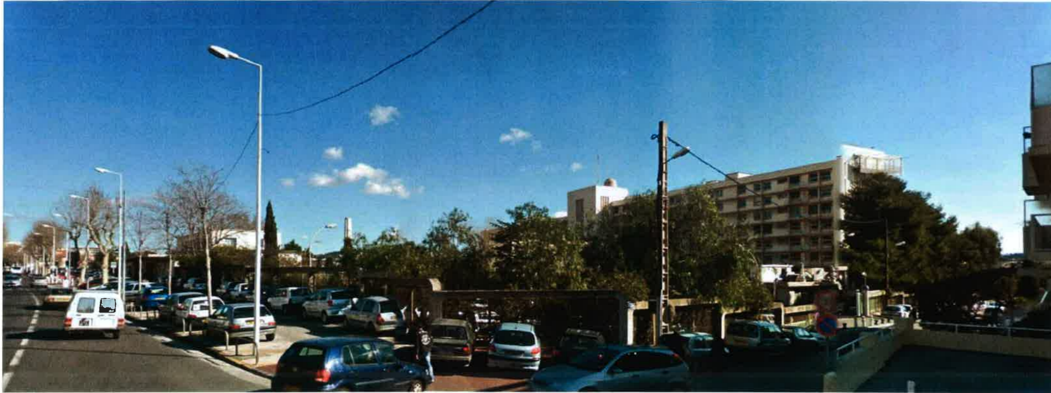
PHOTOGRAPHIE DE L'EXISTANT
