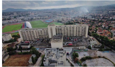
Vue aérienne avec stage léo Site avant travaux Lagrange en contrebas
