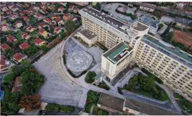
Site avant travaux
