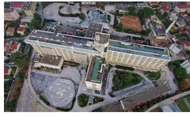
Site avant travaux
