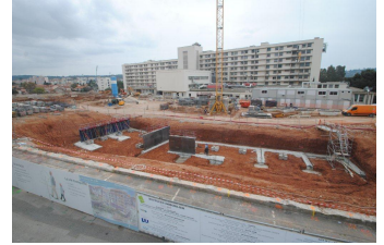
Fondations bâtiment 1 et hôpital en arrière-plan non encore démoli
