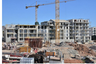
Phase de construction de la première tranche
