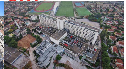
Site avant travaux
