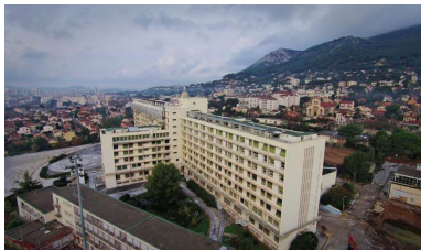
Site avant travaux
