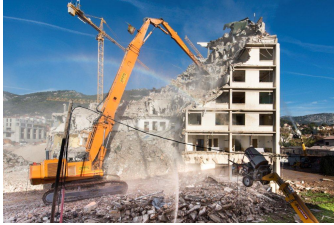
Déconstruction de l'hôpital
