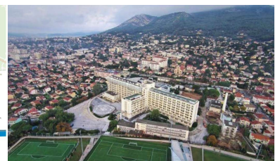
Site avant travaux
