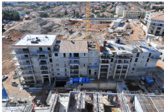
Construction bâtiments 4 et 8
