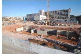
Fondations bâtiment 1 et hôpital en arrière-plan non encore démoli
