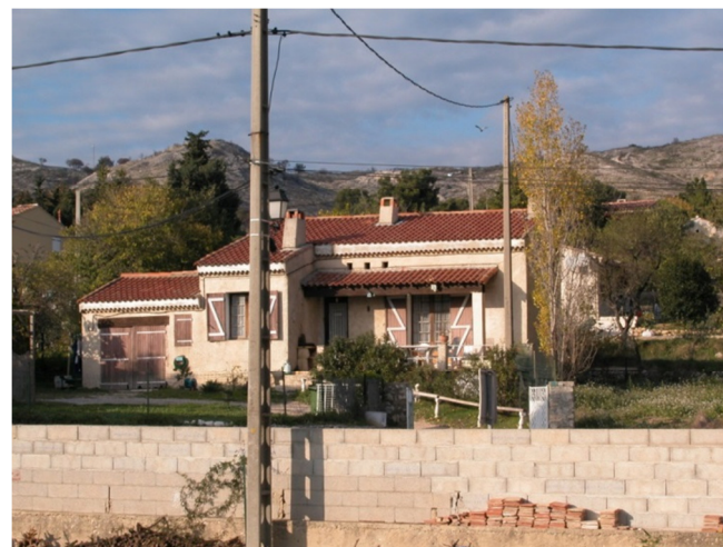
Maison à démolir
