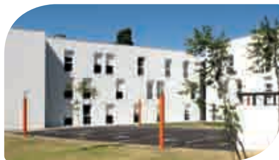
Vitrolles, La Garidelle, nouvelle construction livrée au titre de la reconstitution de l'offre (démolition)
