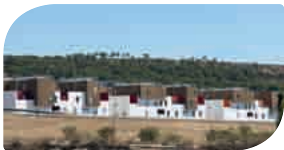
Vitrolles, Les Patios, nouvelles constructions livrées au titre de la reconstitution de l'offre (démolition)
