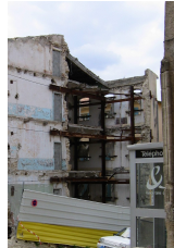
EcoQuartier Historique - Pendant les travaux
