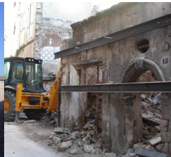
EcoQuartier Historique - Pendant les travaux
