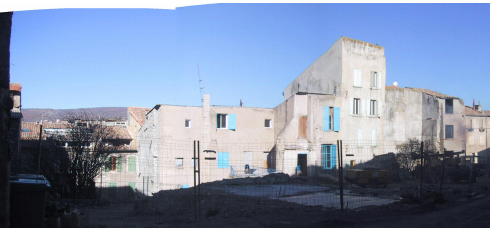
EcoQuartier Historique - Pendant les travaux
