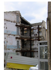
EcoQuartier Historique - Pendant les travaux
