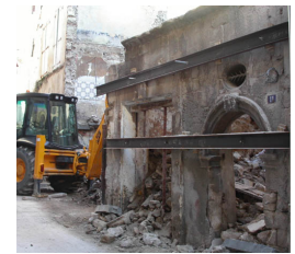
EcoQuartier Historique - Pendant les travaux
