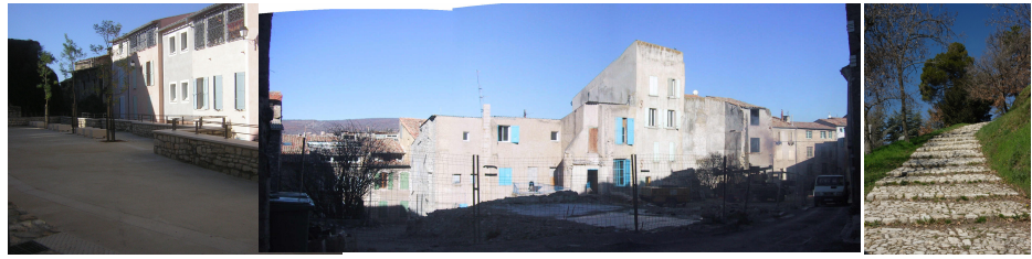
Esplanade Marius Debo - EcoQuartier Historique - Pendant les travaux (livraison)
