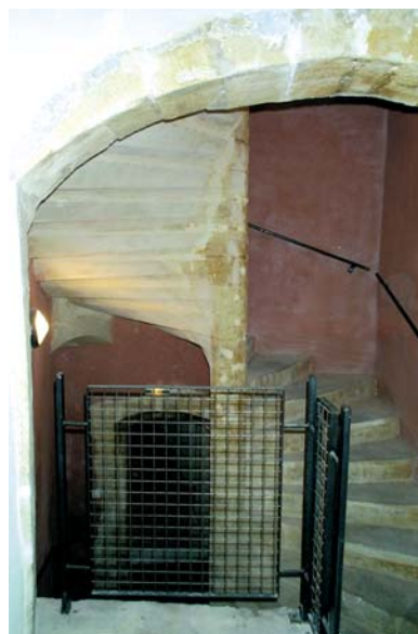
L'escalier à vis, en pierre, restauré
