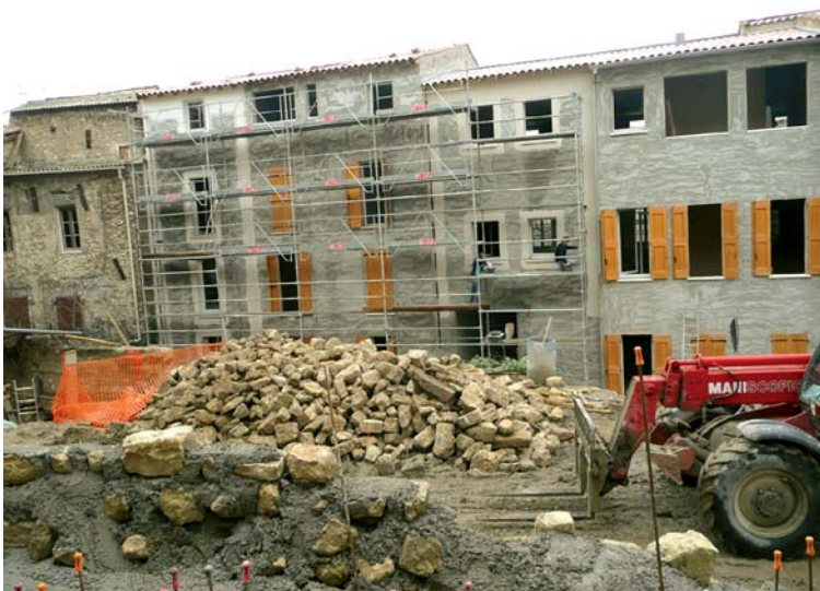
L'immeuble Mousquet-Carmona, en travaux : façades sur l'esplanade
