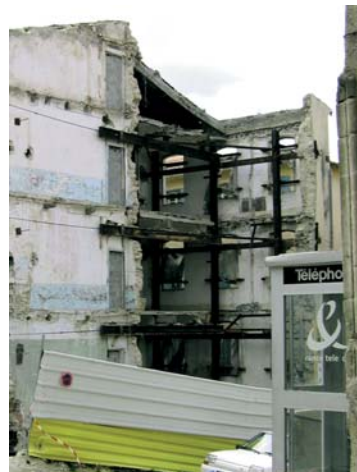
Vues de la structure métallique de confortement
