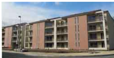
pendant le chantier : Vue sur des logements en cours de finition
