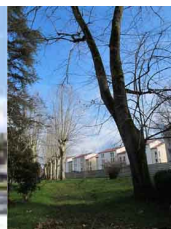
pendant le chantier , Petits collectifs réhabilités
