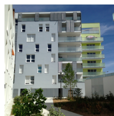
Logements collectifs côté Avenue Reinson
