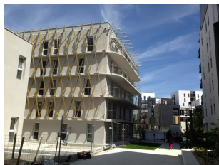
Îlot Orion en construction
