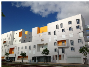
Vue d'ensemble d'un bâti Ely côté Cours de Québec
