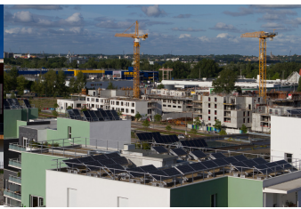
Panneaux solaire de Gallée
