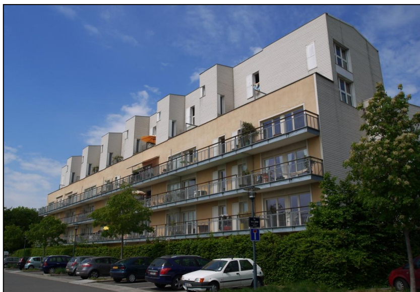
Figure 52 : L'immeuble Salvatierra à Beauregard
