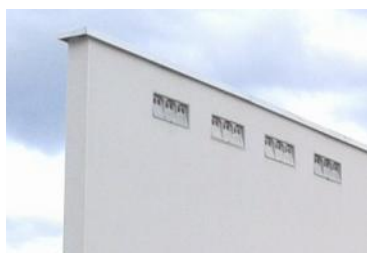
Quartier de la Barberie à Changé : intégration de nichoirs dans le bâti.
