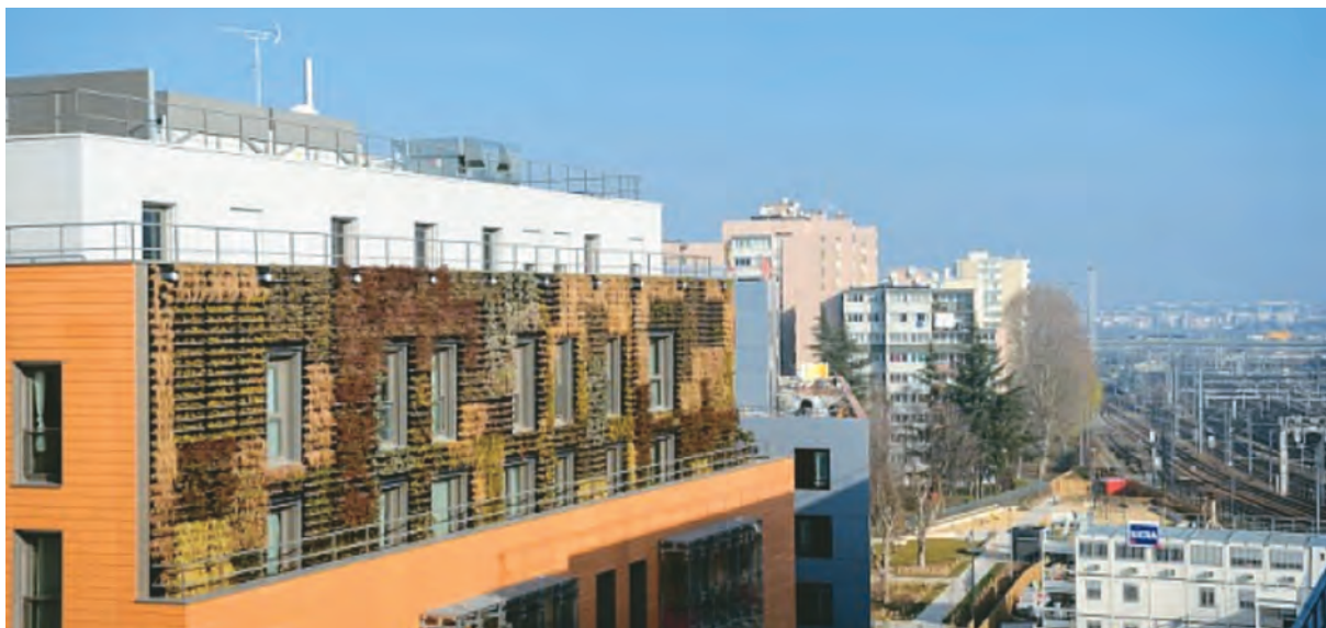
Figure 8 : Le mur du pôle d'entreprises « Paris Région Innovation Nord Express » a été végétalisé : un dispositif permettant de lutter contre le phénomène d'îlots de chaleur urbains - Source : © Arnaud Bouissou/MEDDE-MLET
