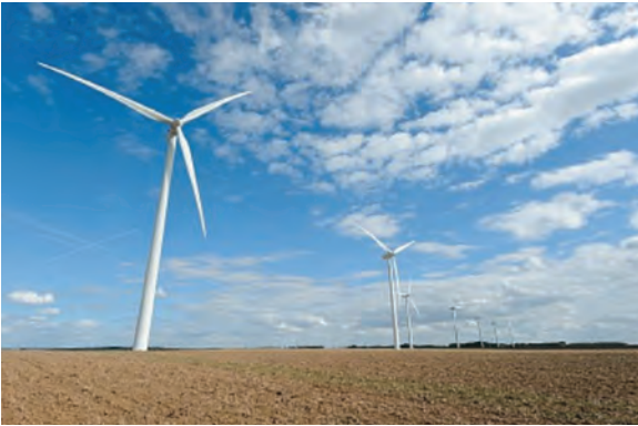
Figure 2 : Sur la commune de Charly-sur-Marne, le Parc éolien de la Picoterie a vu le jour en 2009, année du lancement de la directive EnR. Onze éoliennes ont été mises en service sur le site. Ces aérogénérateurs fournissent de l'électricité au réseau national : ensemble, elles produisent 55 GW/h. Source : © Arnaud Bouissou/MEDDE-MLET.
