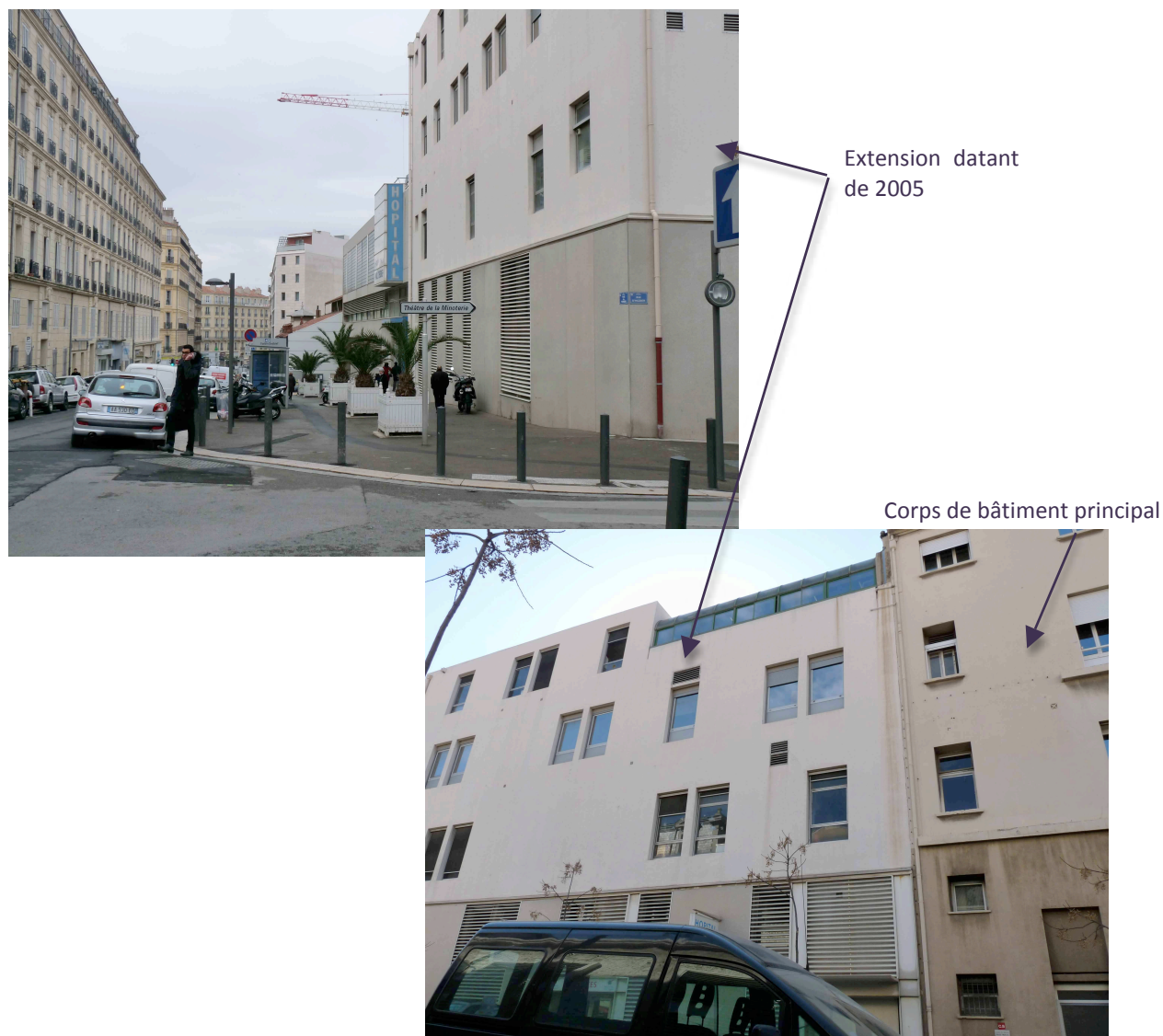
Figure 64 Différentes parties de l'hôpital Desbief
