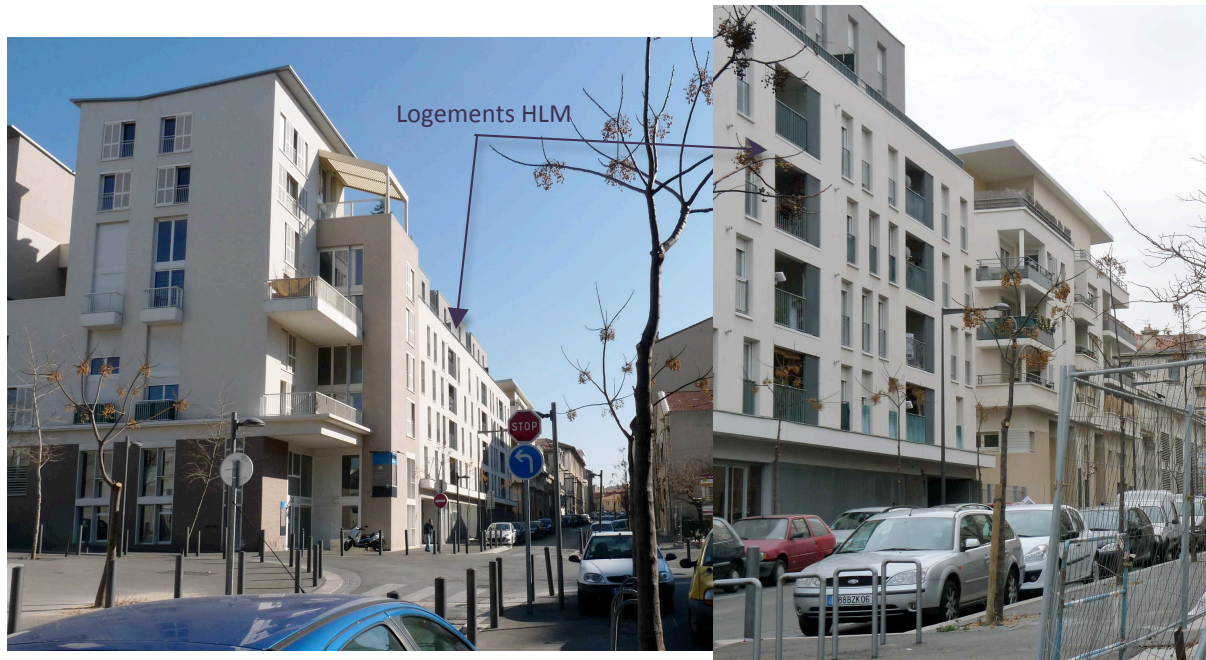
Figure 53 L'îlot M5, façades sur rue depuis le trottoir opposé rue d'Hozier
