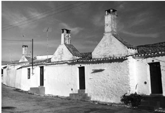
Ancien village: façades sur rue
