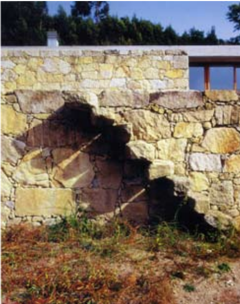
Escaliers extérieurs intégrés
