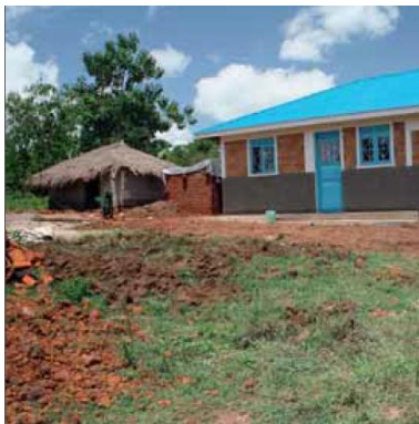
Bâtiments ISSB à Lira
