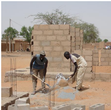
Construction d'infrastructures sanitaires
