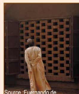
Source : Fuergando.de Mur en briques de terre
