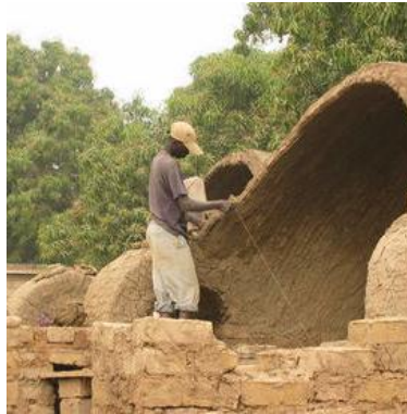
Construction d'une voûte
