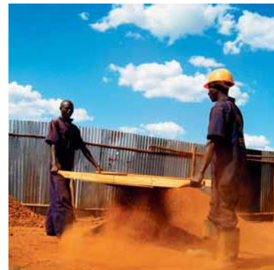
Ouvriers sur un chantier ISSB
