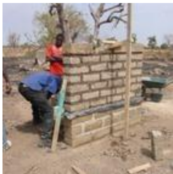
Artisans construisant un mur à Ouagadougou
