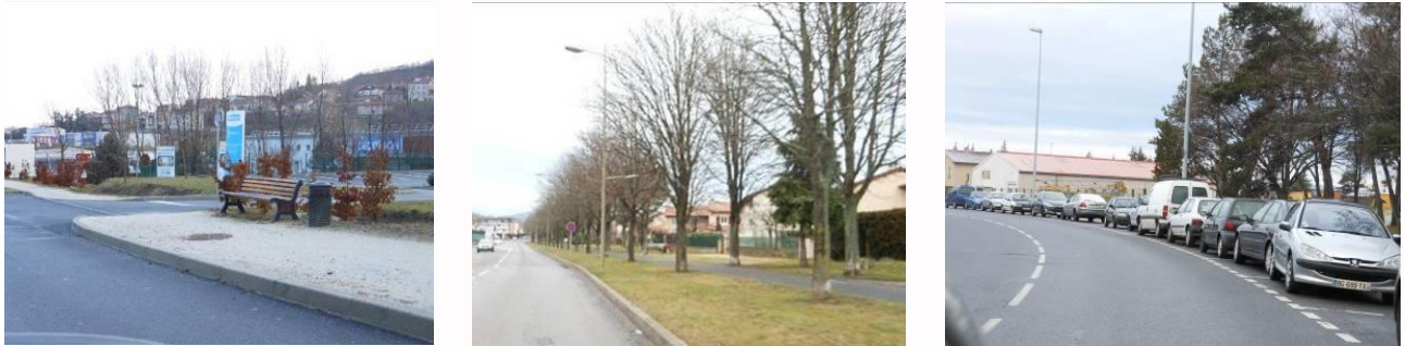
Exemple : Aménagement paysager des espaces publics, aménagement de cheminement piétonniers et trottoirs – ZA de Chirel et ZA de Corsac – Brives-Charensac ; Organisation des stationnements – ZA de Taulhac
