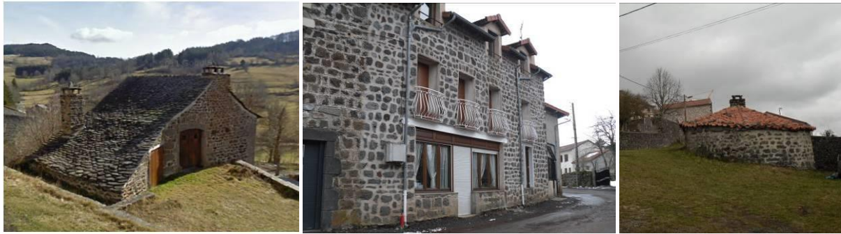
Habitation avec toiture de Lauze ou de tuile, façades en pierre – Montusclat, Cayres et Hameau de Vendo à Loudes
