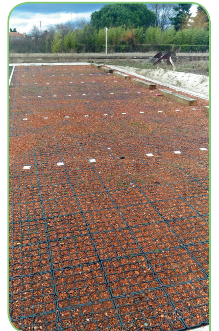
Dalles alvéolaires avec mélange terre/pierre sur rue Sylvain Girerd • Bonson
