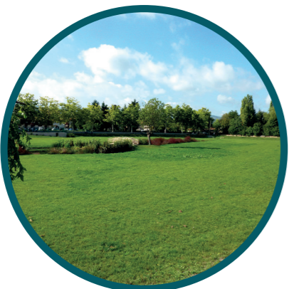
Bassin de rétention paysager le panorama • Montbrison
