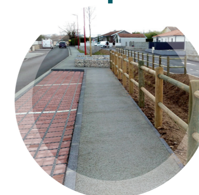
Revêtements poreux à Craintilleux
