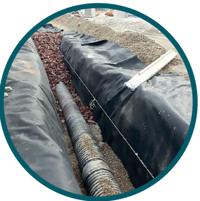
Tranchée drainante cinéma Family • Saint-Just Saint-Rambert
