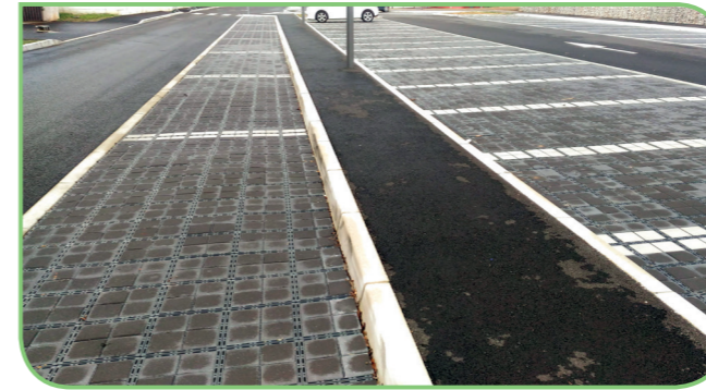
Dalles pavées parking rue de la Madone • Sury-le-Comtal
