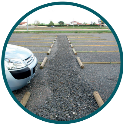
Tranchée d'infiltration aire de covoiturage Saint Côme • Saint-Just Saint-Rambert
