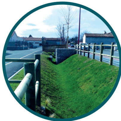
Noue enherbée rue du midi • Crainvilleux
