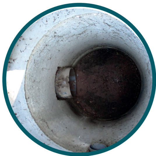
Puits d'infiltration rue de la Rive • Saint-Cyprien
