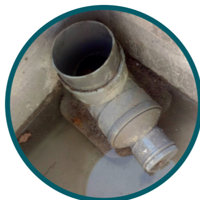
Ajutage circulaire aire de covoiturage • Montbrison
