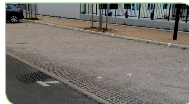
Dalles alvéolaires avec gravillonnage sur parking rue Massenet • Bonson
