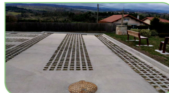
Parking béton coulé rue centrale • Saint-Georges- Haute-Ville
