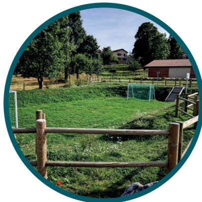
Bassin de rétention multi-usages • Chazelles-sur-Lavieu
