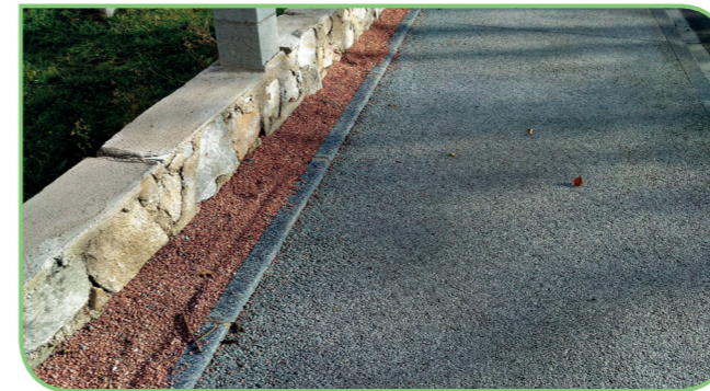
Béton poreux sur les trottoirs rue du midi • Craintilleux
