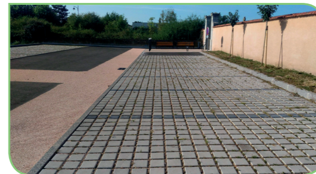
Pavés non jointés, aménagement cimetière • L'Hôpital-le-Grand
